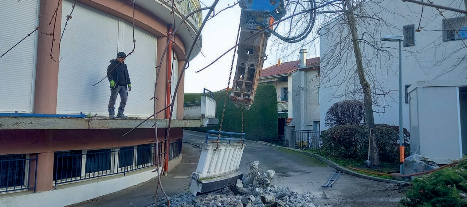
Démolition du balcon
