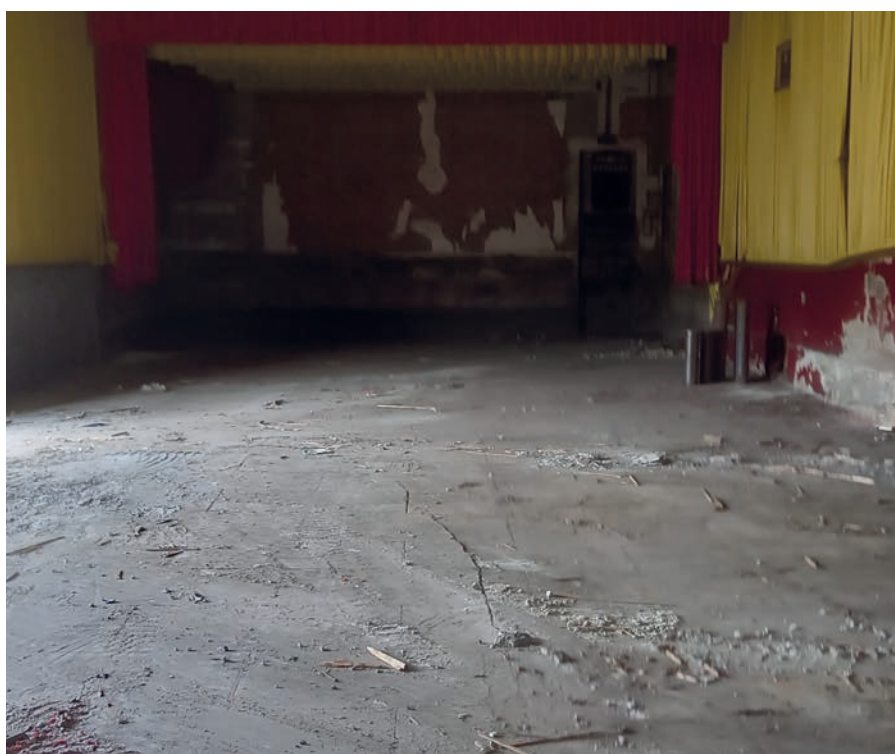
Vue de la salle après dépollution et avant déconstruction
