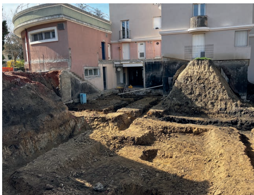
Terrassement pour implanter le restaurant scolaire
