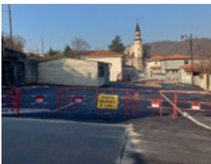
Le parking réalisé
