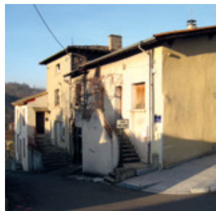
Vue côté rue Prost- Grivet
