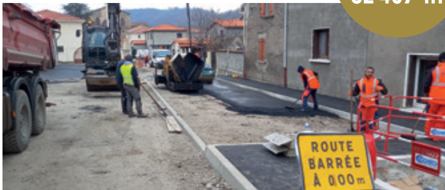
Travaux en cours
