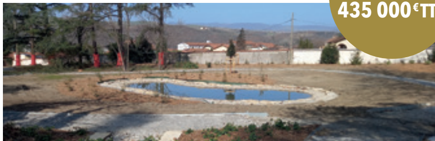
Les travaux du bassin
