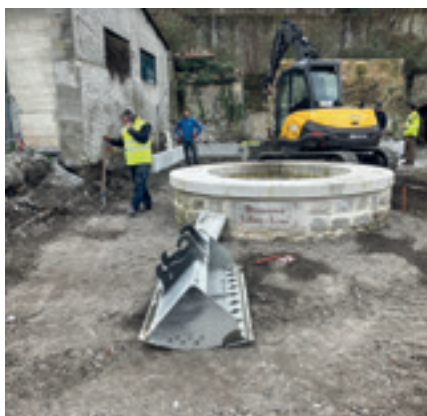
L'entreprise DEGRUEL en plein chantier
