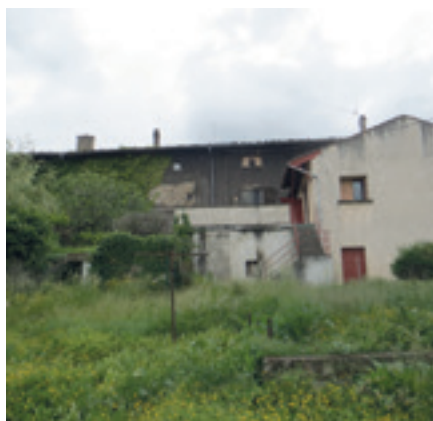
Vue NORD - côté SNCF/ EGLISE
