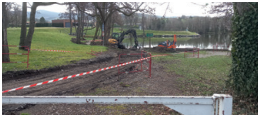
Vue des travaux depuis le parking
