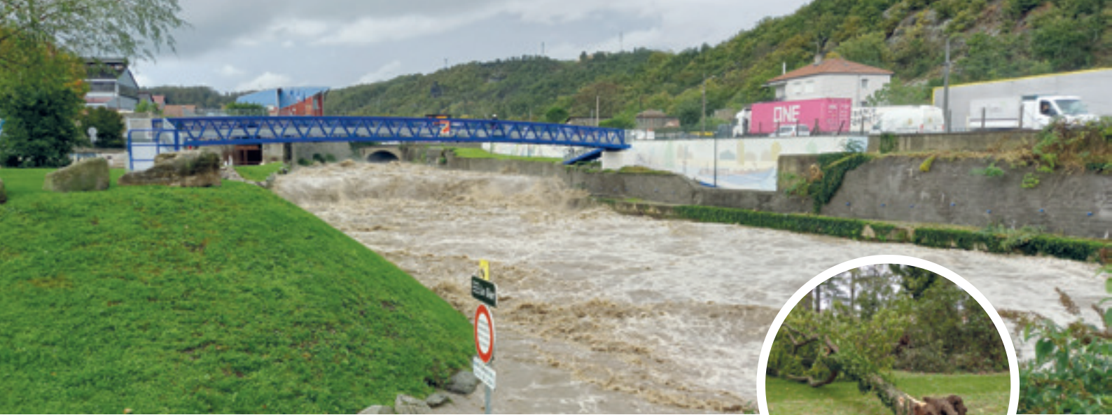
La rivière le Gier le 17 octobre 2024 à la limite de la crue centennale
