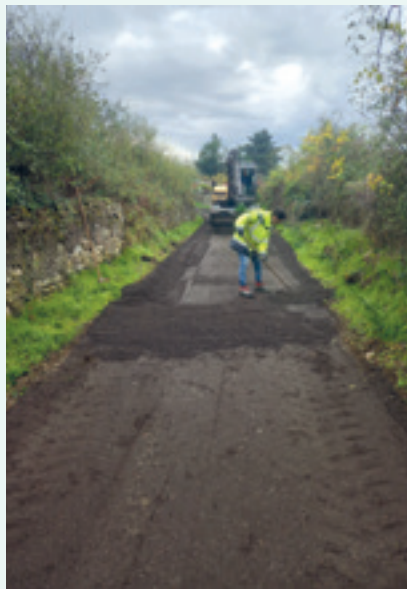
Remise en état du chemin des Crest
