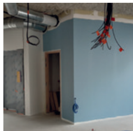
1 er étage entrée ascenseur
