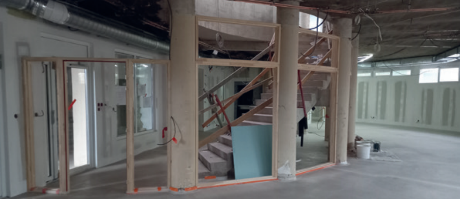
Vue du RDC de la ludothèque relié à l'étage bibliothèque par un escalier et un ascenseur
