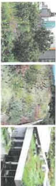
Toitures terrasses : intensive / semi-intensive / extensive
